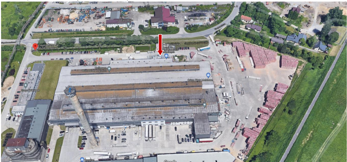
Ciepłownicza 54 – widok części nieruchomości z lotu ptaka
